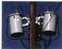
图25-15 降压变压器将输电线上的高电压降低到消费者所需要的低电压。
